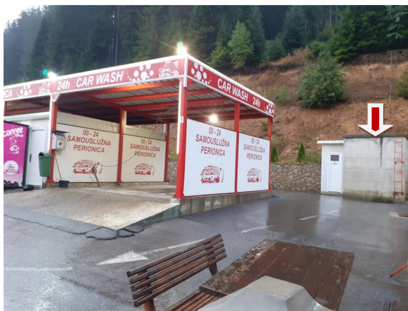
Sl.23 Namjenski separator zapremine 12m 3
