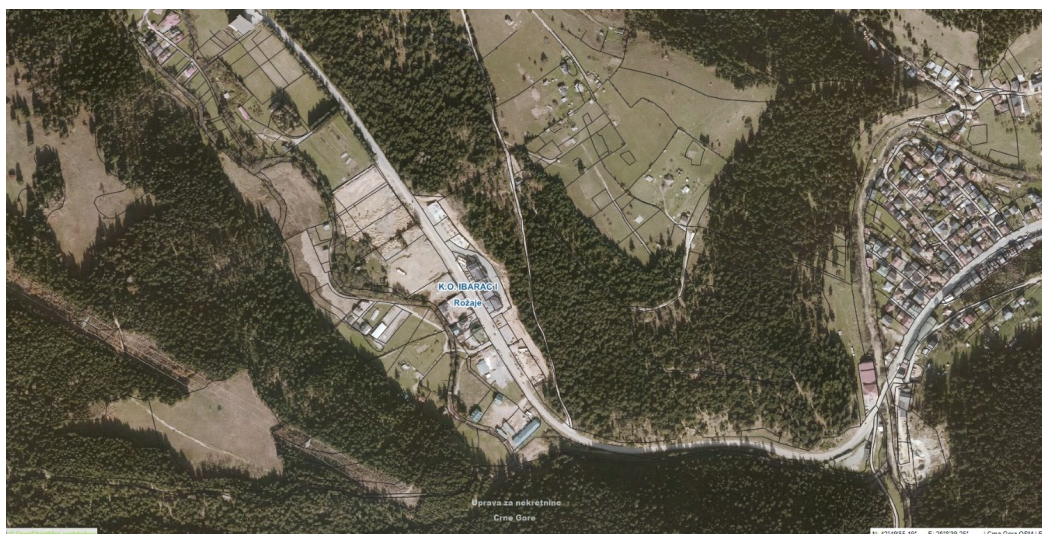
Slika 2.2: Širi prikaz lokacije objekta (izvor: Geoportal CG)
